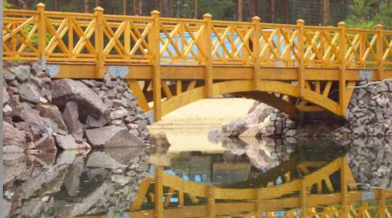
Ultralam™ yra kompozicinis medienos produktas, kuris fizinėmis ir mechaninėmis savybėmis lenkia medžio masyvą ir klijuotąją sluoksninę medieną. Šios medžiagos plokštės ir ruošiniai yra gaminami taikant keletą faneros orientavimo būdų, naudojant skirtingas faneros rūšis, ir pateikiamas platus matmenų diapazonas. Ultralam™ yra sertifikuotas pagal Europos, Rusijos, Australijos ir JAV kokybės standartus.
